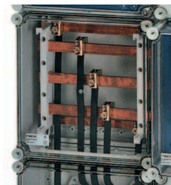
Układ szynowy 250A. Zastosowanie zacisków szynowych i szyn elastycznych
